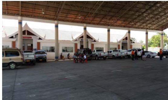
อาคารปฏิบัติงาน CCA ฝั่ง สปป.ลาว
