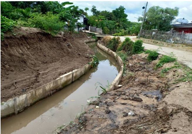
งานก่อสร้างระบบส่งน้ำฝิ่งขวา
