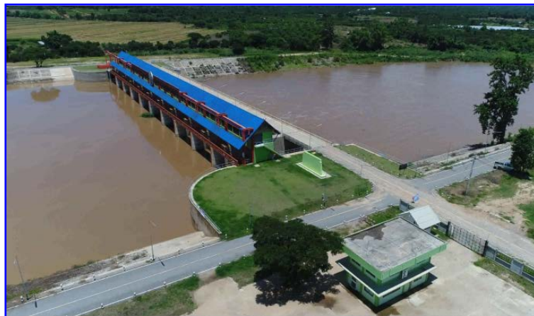
งานก่อสร้างประตุน้ำห้วงงานและอาคารประกอบ
