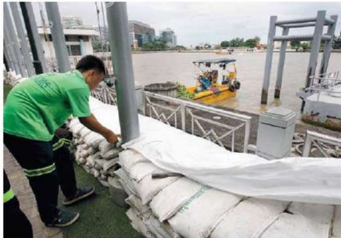
เตรียมพร้อม - เจ้าหน้าที่จากกรุงเทพมหานคร (กทม.) กำลังเรียงกระสอบทรายป้องกันน้ำท่วม ภายหลังมีรายงานว่ามวลน้ำจากภาคเหนือ จะไหลลงมาถึงกรุงเทพฯ ภายใน 7 วันข้างหน้า เพื่อป้องกันไม่ให้น้ำไหลเข้าสู่พื้นที่ด้านในและกระทบต่อประชาชน ณ อาคารส่วนการท่องเที่ยว ริมน้ำเจ้าพระยา ได้สะพานสมเด็จพระปิ่นเกล้า
