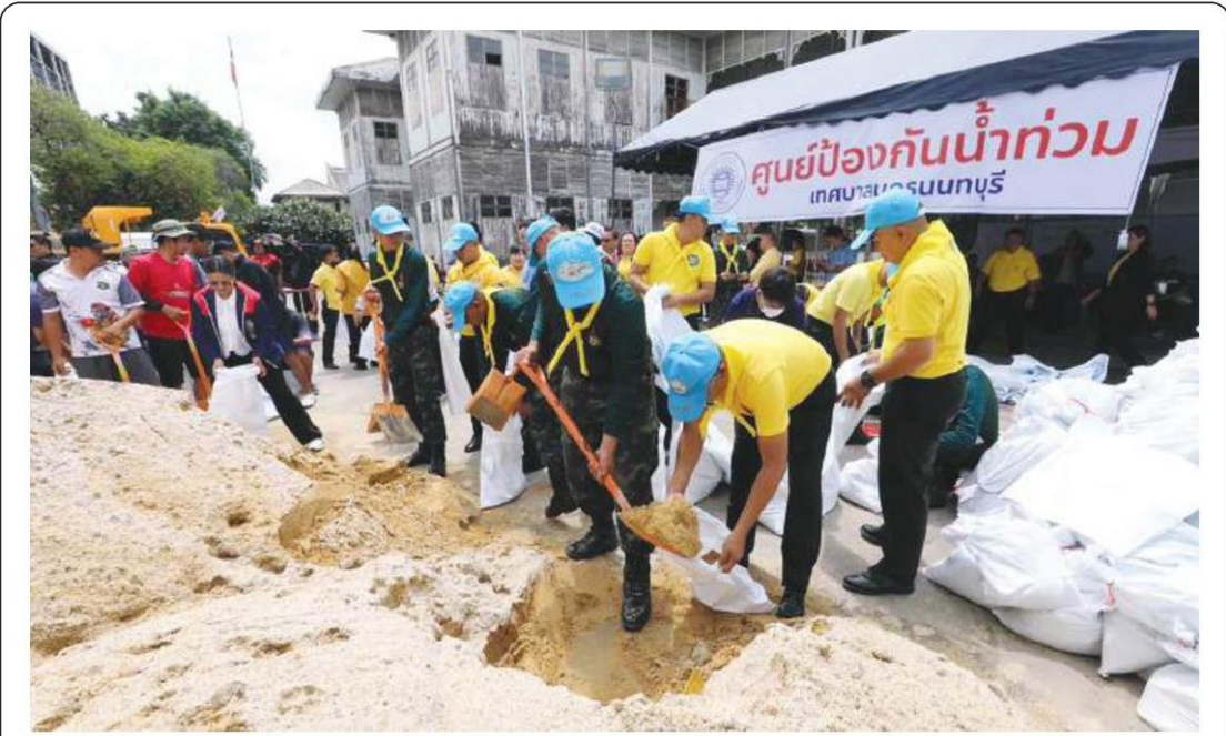
เตรียมรับมือมวลน้ำ - ที่ศูนย์ป้องกันน้ำท่วม เทศบาลนครนนทบุรี เจ้าหน้าที่เทศบาลกำลังบรรจุกระสอบทรายเพื่อนำไปวางตามแนวริมแม่น้ำเจ้าพระยา ซึ่งเป็นจุดลุ่มเสี่ยงและลุ่มต่ำ พร้อมติดตั้งเครื่องสูบน้ำเตรียมรับมือเพื่อรับมือกับมวลน้ำจากภาคเหนือ ที่จะไหลลงมาถึงจังหวัดนนทบุรี
