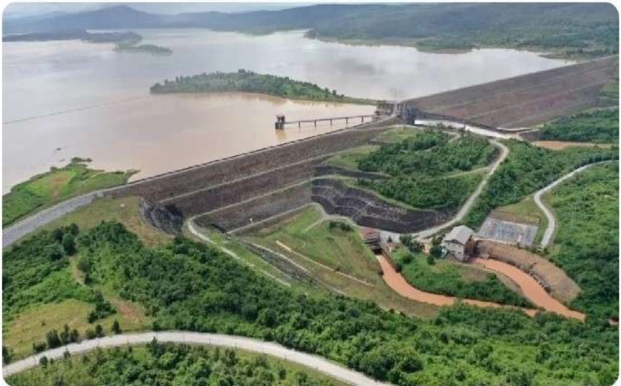
ยืนยันน้ำเพียงพอ ไม่แล้ง
