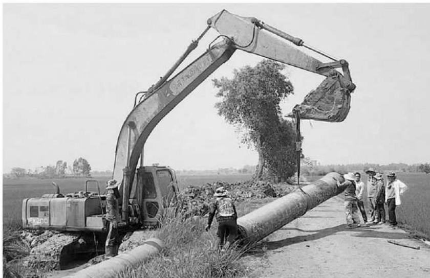
เพิ่มประสิทธิภาพ - ชลประทานพิจิตรเร่งก่อสร้างโครงการก่อสร้างอาคารบังคับน้ำคลองหนองจอกพร้อมระบบส่งน้ำ ต.หอไกร อ.บางมูลนาก จ.พิจิตร เพิ่มประสิทธิภาพให้กับสถานีสูบน้ำด้วยไฟฟ้าบ้านย่านท่าเสา พร้อมระบบส่งน้ำให้นาข้าวกว่า 2,000 ไร่
