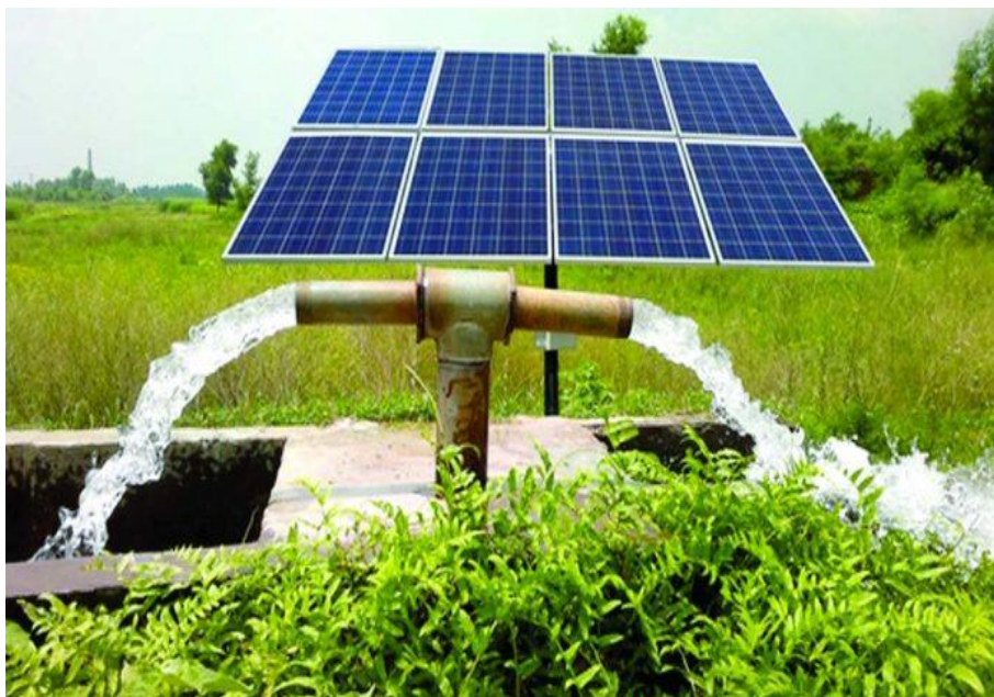
รูปที่ 18: ระบบชลประทานพลังงานแสงอาทิตย์ ปั๊มทำงานด้วยไฟฟ้าที่ผลิตจากแผงโซลาร์เซลล์ 2
