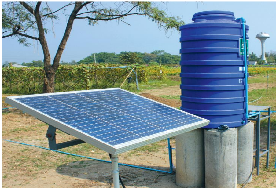
รูปที่ 18: ระบบชลประทานพลังงานแสงอาทิตย์ ปั๊มทำงานด้วยไฟฟ้าที่ผลิตจากแผงโซลาร์เซลล์ 2
