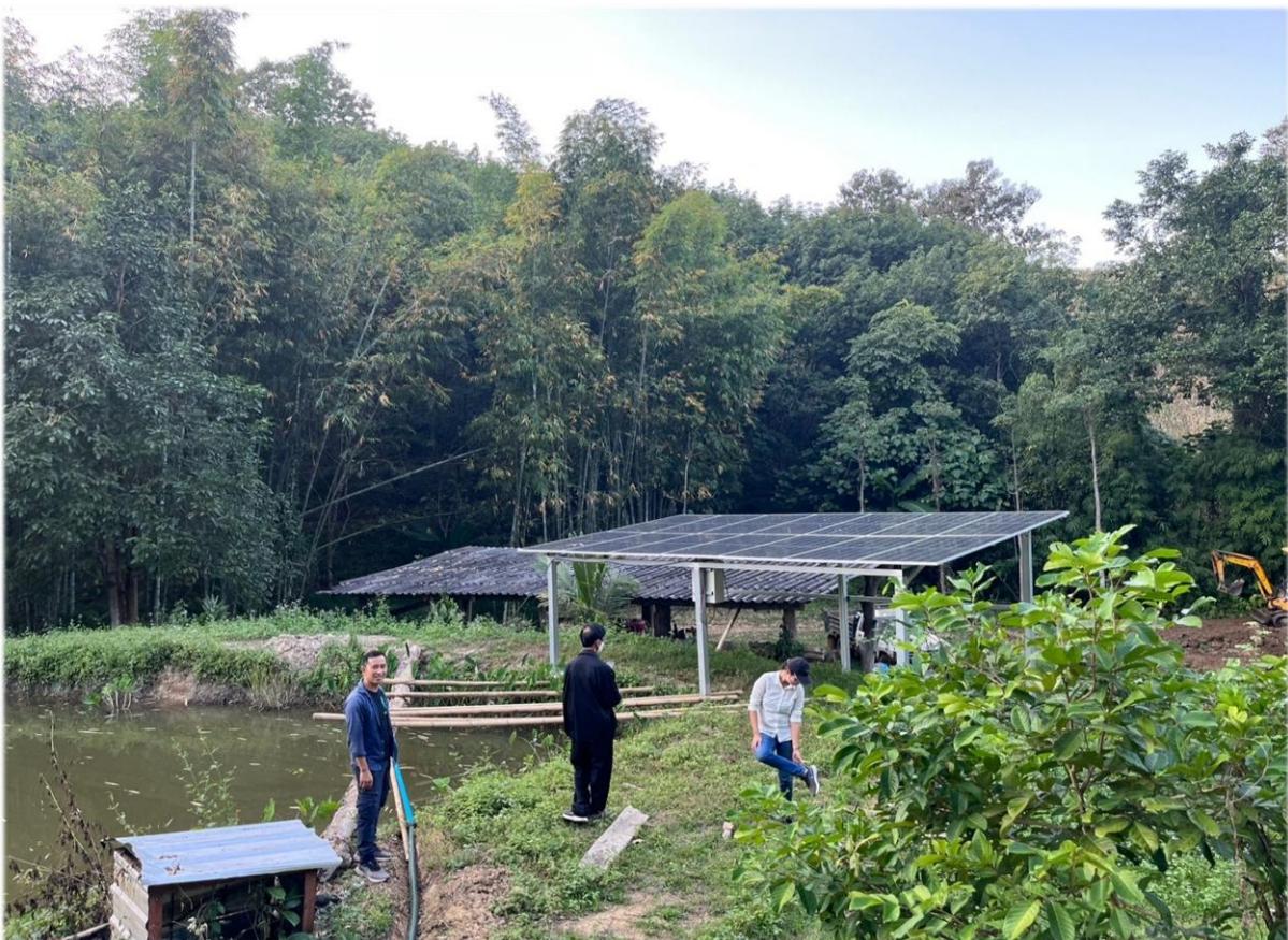
ตำบลบัวใหญ่ อำเภอนาน้อย จังหวัดน่าน: การใช้งานระบบชลประทานพลังงานแสงอาทิตย์ในไร่นา ที่มา: ผู้เขียน
